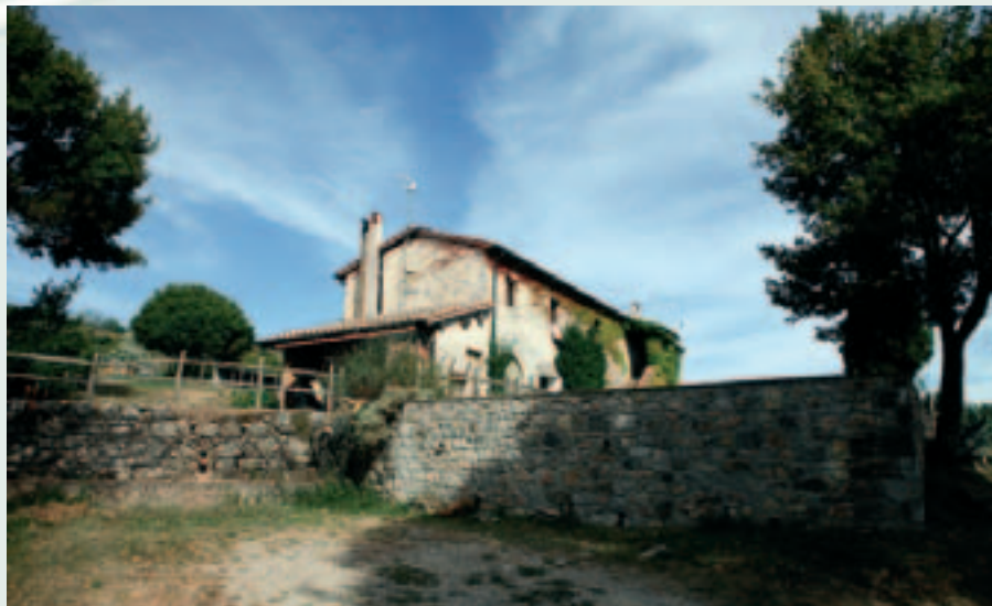
Der Pferdestall liegt etwas abseits von den Wohnhäusern.
